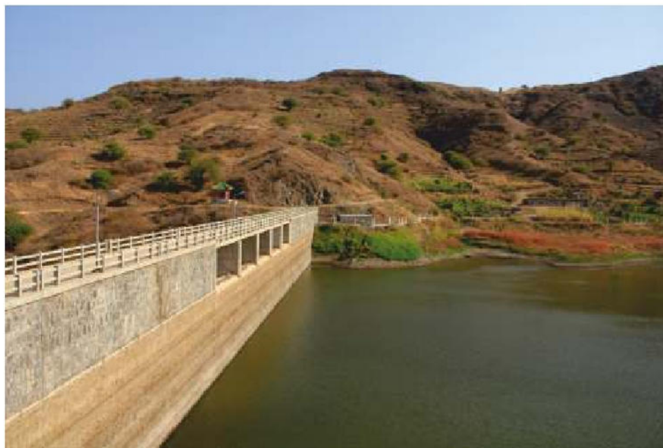
Barragem de Poilão // Dam of Poilão // AO
